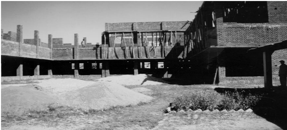
Das halbfertige Gebäude des Kindergartens im April 1999
